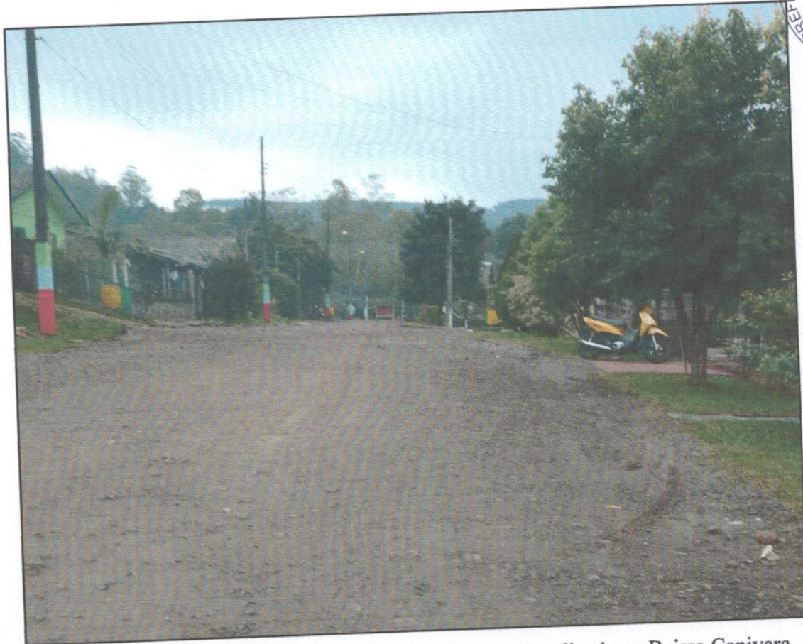
Figura 10: Trecho a ser pavimentado na Rua Primavera, localizada no Bairro Capivara.
