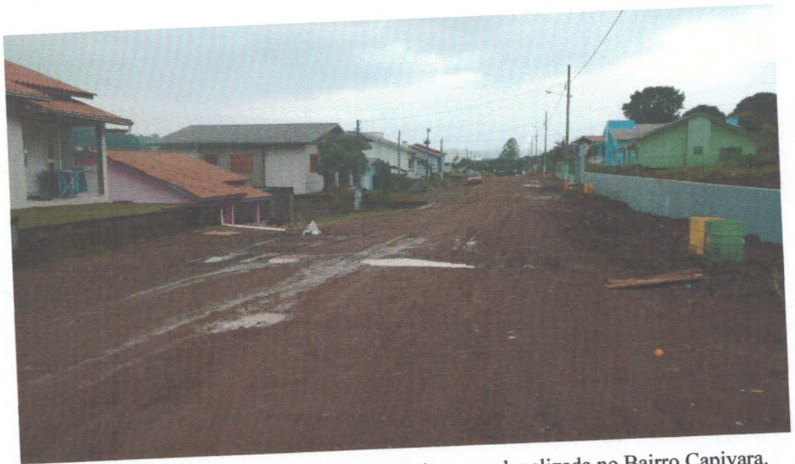
Figura 8: Trecho a ser pavimentado na Rua Primavera, localizada no Bairro Capivara.
