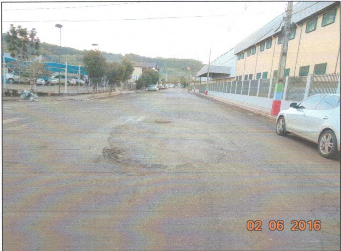
Figura 5: Via com desgastes superficiais e profundos com deformações e perda de material granular.
